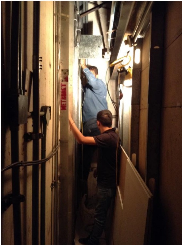
Instalación de tubería
