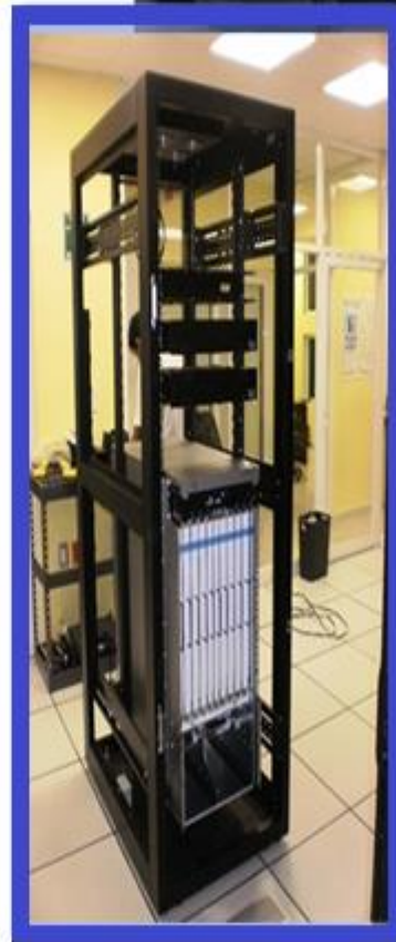
4. Montaje de repisa e instalación de organizadores.
