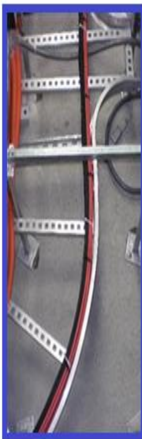
3. Fijación de cable por escalerilla
