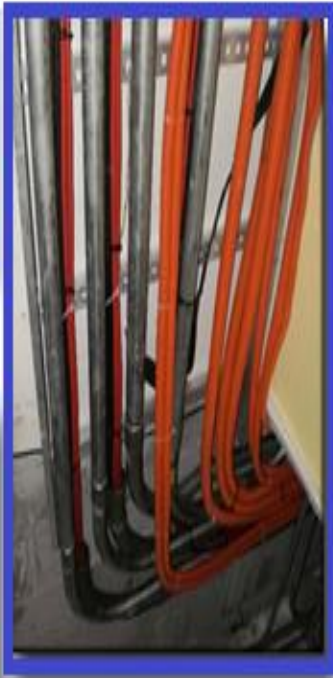
7. Tendido de centro de carga.
