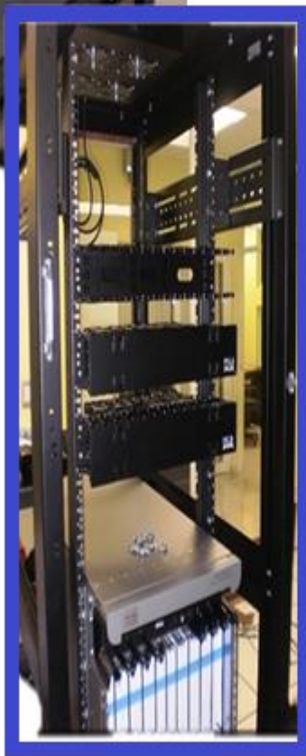
3. Instalación de organizadores para cableados internos.
