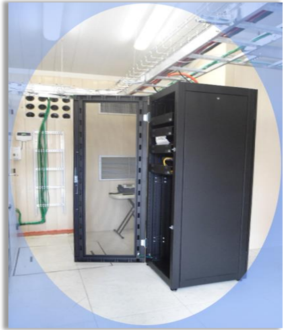
Escalerilla de aluminio para datos fuerza y Charofil para F.O
