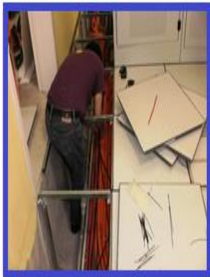
3. Fijación de cable por escalerilla
