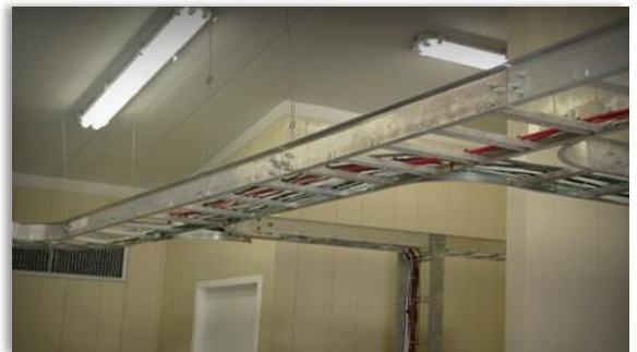
Canalización de site con escalerilla de 12".v
