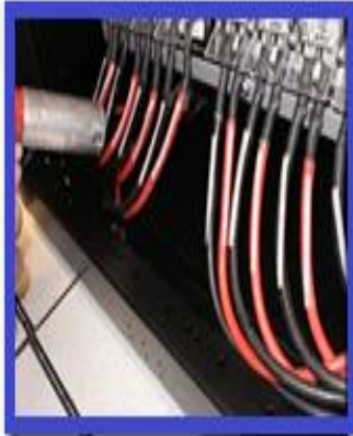
6. Etiqueta de fuentes y cubierta con termofil.
