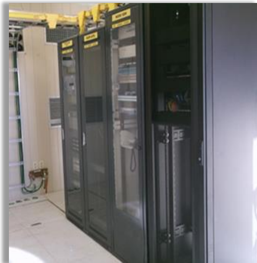
Escalerilla para tierra física.
