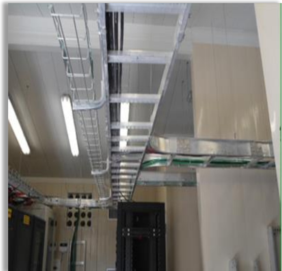
Canalización de site con escalerilla de aluminio y Charofil de 100mm.
