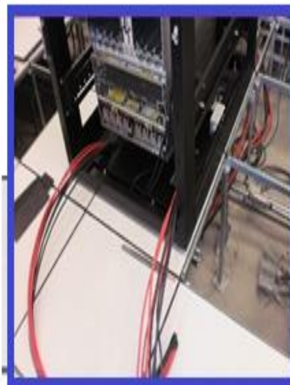
2. Salida de Cable por ranuras del gabinete
